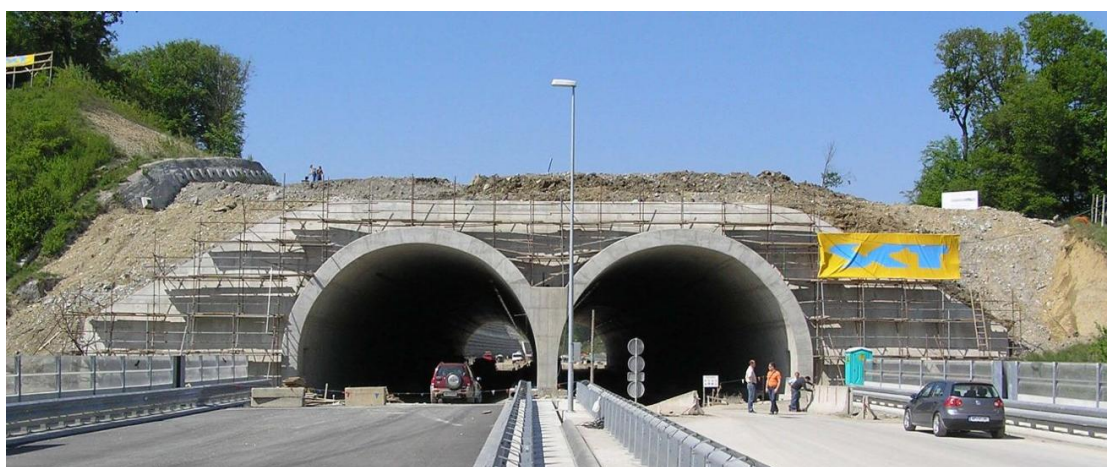
Tunel 'Artificial' în formă de boltă, realizat la zi (Maribor, Slovenia)
